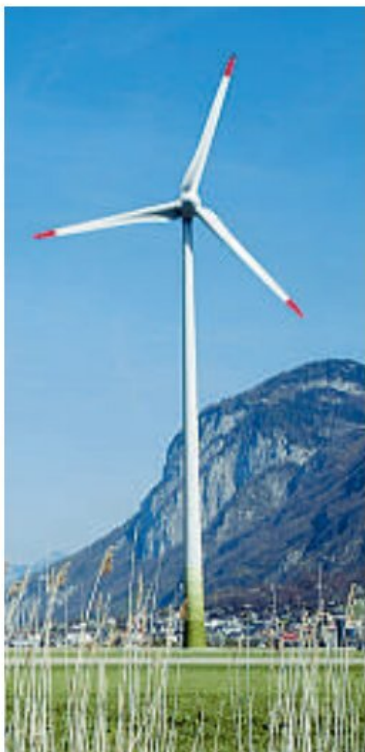
WEA bei Collonges (VS), 2 MW, Nabenhöhe 100 m (Foto Suisse Eole)
