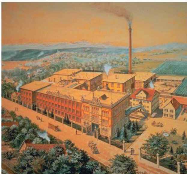
Altes Fabrikgebäude in Kilchberg.
